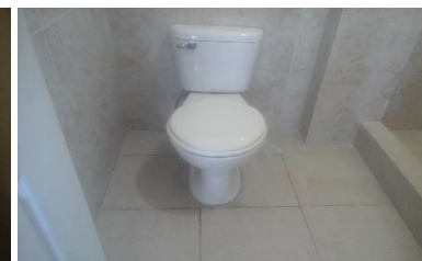
ADECUACIÓN DE LOS BAÑOS
