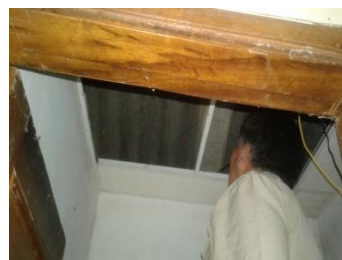
CAMBIO DE TECHO
