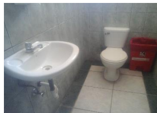
ADECUACIÓN DE LOS BAÑOS
